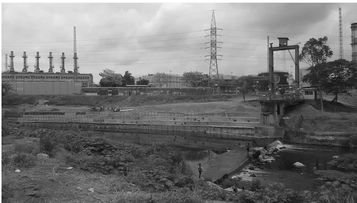
Photo 8 : La centrale thermoélectrique d'Esmeraldas et les travaux de protection contre l'érosion en rive gauche du Teaone
