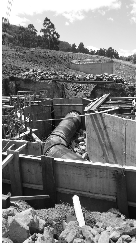
Photo 7 : Les by-pass, une pièce sensible de l'alternative des passages élevés
