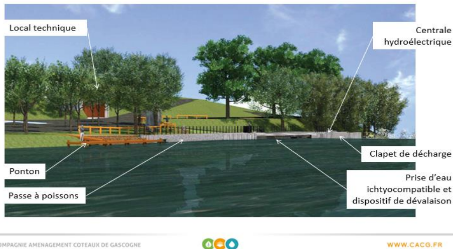
Figure 31 : l'aménagement du seuil de Païchérrou à Carcassonne : centrale hydroélectrique et passe à poisson ; Source, CACG, 2017
