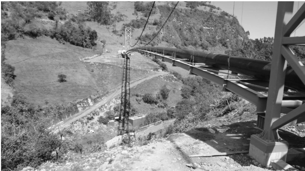
Photo 6 : Un passage élevé de l'aqueduc La Mica en fin de travaux
