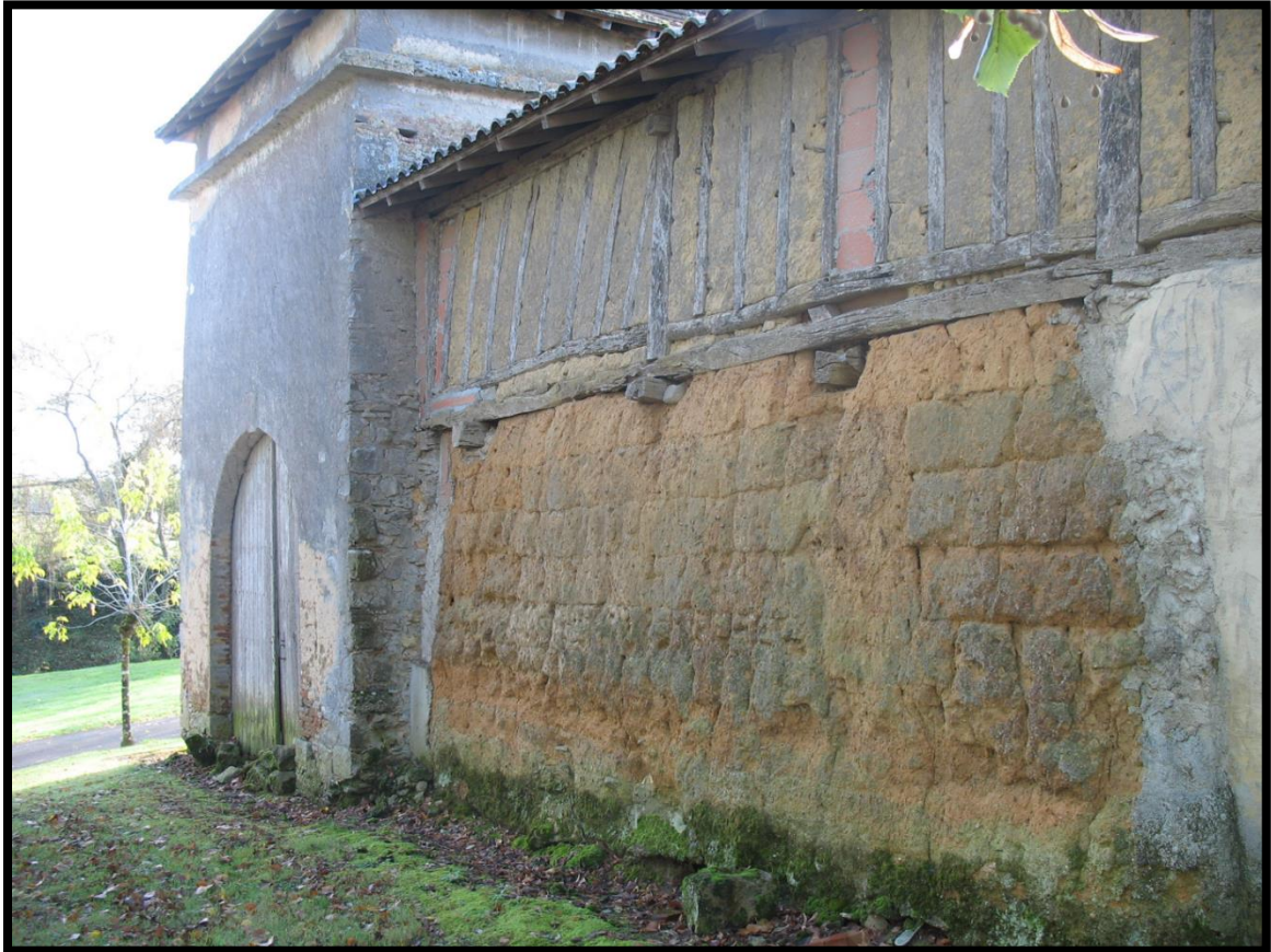
Fig. 17 : Photographie du mur en terre massive et de la porte visibles à l'extrémité nord de plate-forme du Castet, prise depuis le nord (cliché : N. Guinaudeau)
