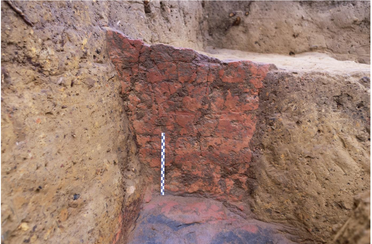
Fig. 23 : Photographie de détail de la paroi occidentale du mur 1005 (Cliché N. Guinaudeau)
