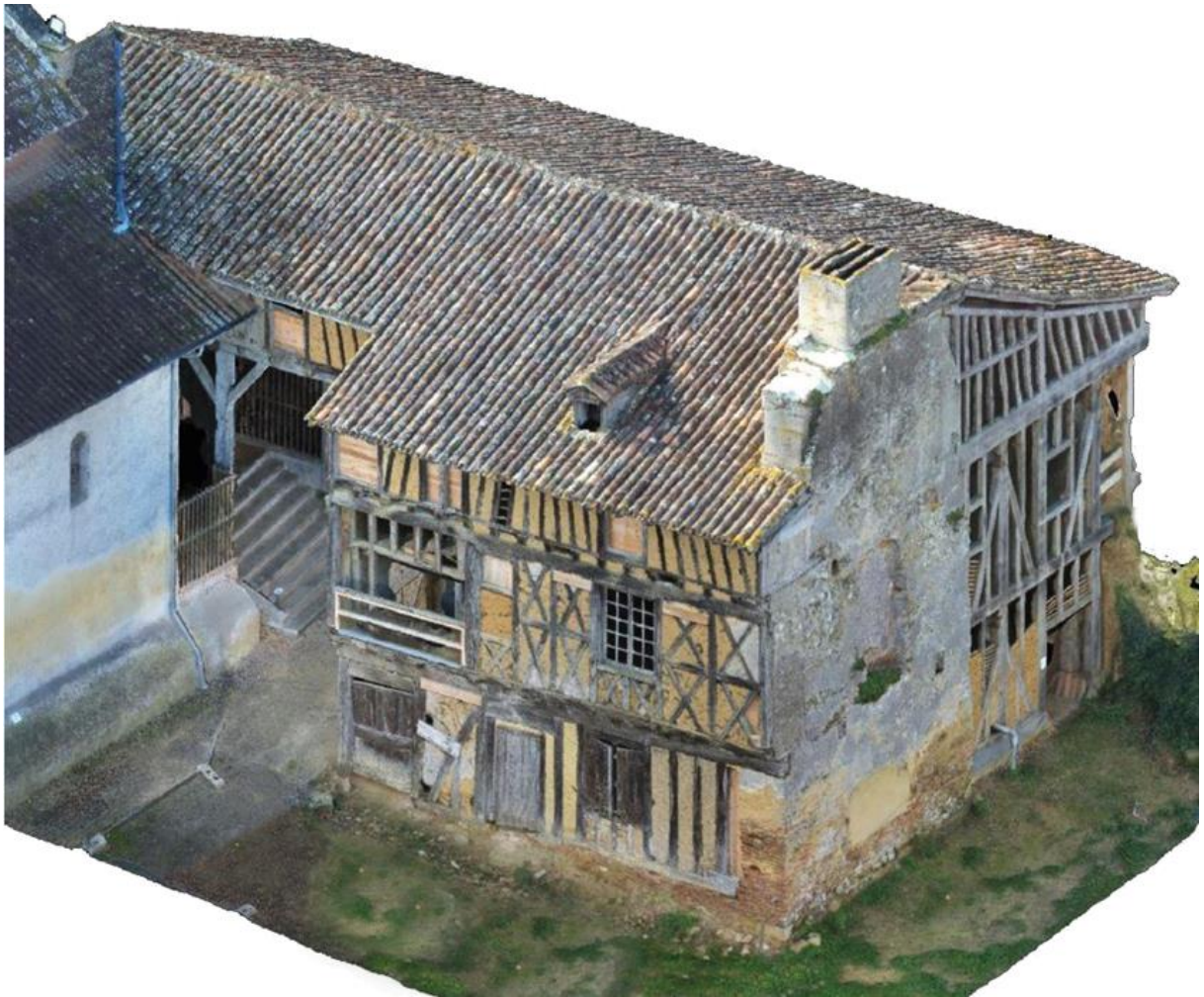
Fig. 20 - Extraction de la modélisation du logis vue du nord est. Maillage texturé du logis (F. Baleux, C. Calastrenc, A. Laurent. TRACES, plateau TIG3D)
