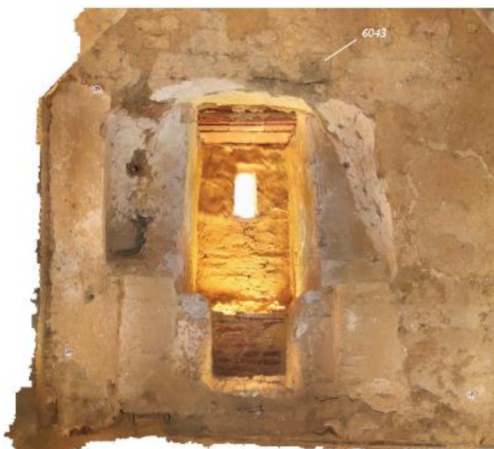
Fig. 29 - Orthophotographie de l'intérieur de la latrine aménagée dans le rempart (S. Durand)
