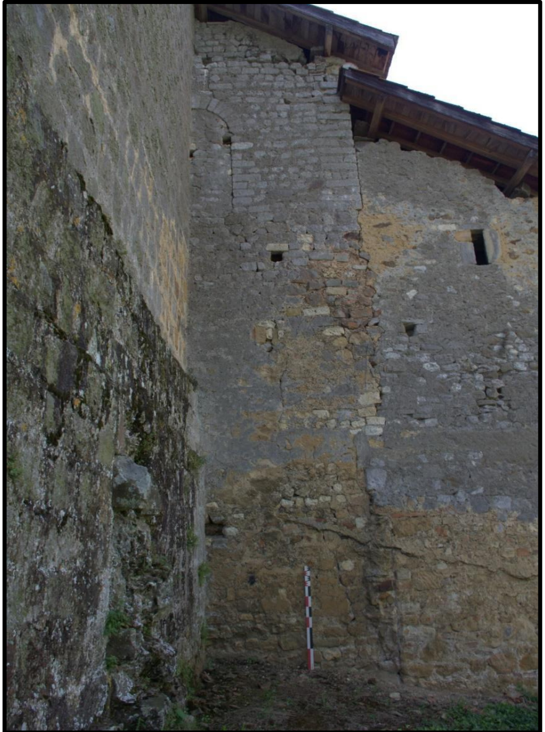
Fig. 13 - Vue du mur en petit appareil du 1 er édifice carolingien au chevet de l'église Saint-Pierre et de la fenêtre (fen 214) (Cliché Y. Matallia)
