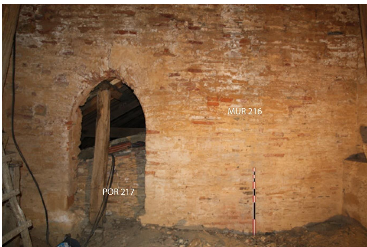
Fig. 17 - Surélévation du mur de chevet en maçonnerie de brique ouvrant actuellement sur les combles de la nef (Y. Mattalia)
