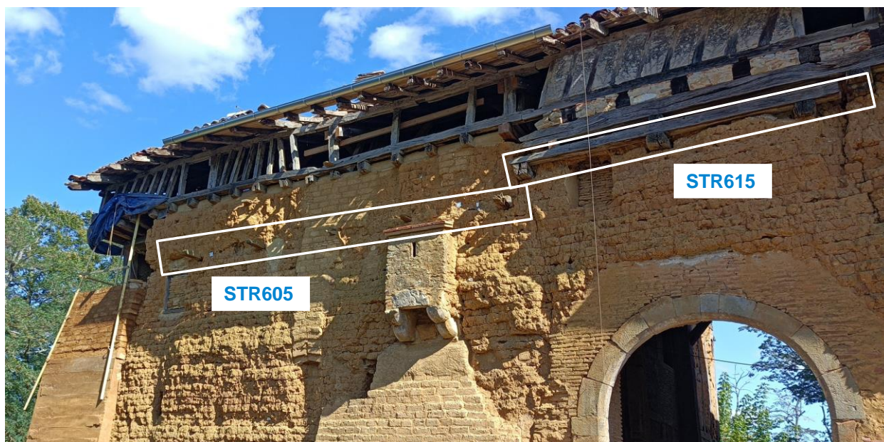
Figure 66 - Liste et localisation des bois échantillonnés dans le rempart en terre crue (STR605 et 615)
