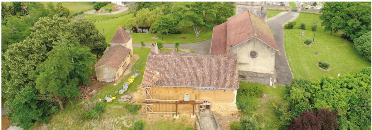
Fig. 65 - Vue aérienne du Castet depuis l'ouest Cliché de S. Durand, extrait du rapport d'opération de Laura Soulard (Soulard et al. 2021)
