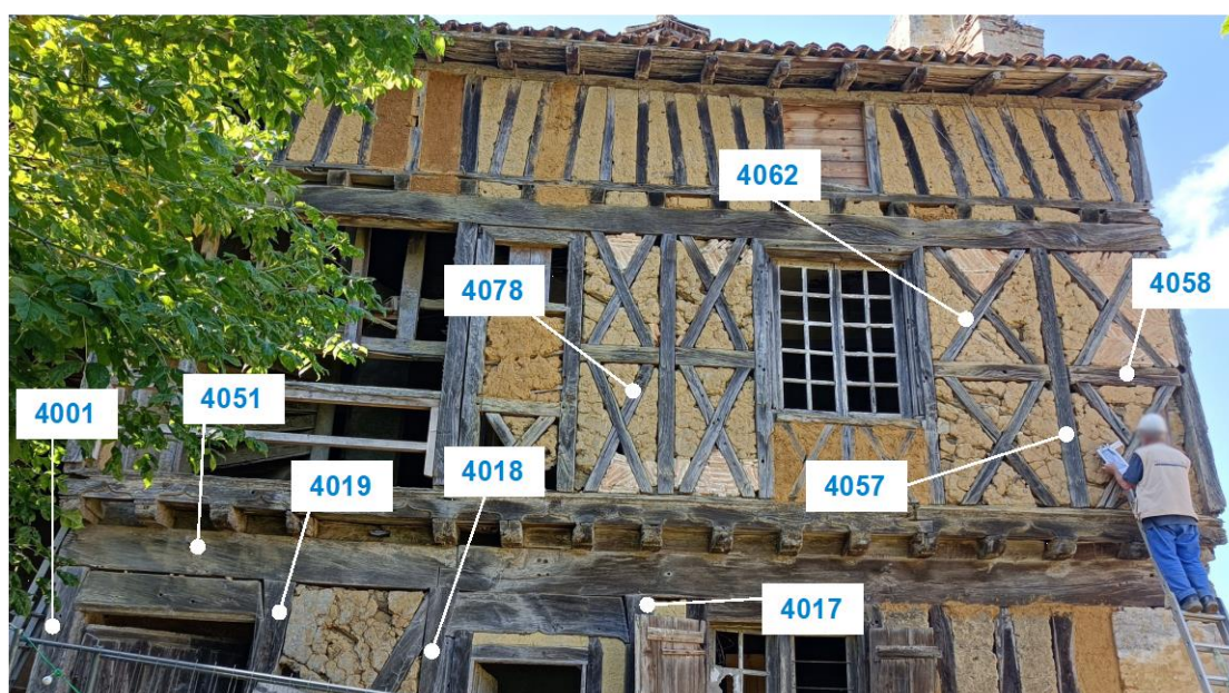
Figure 67 - Liste et localisation des bois échantillonnés dans le logis
