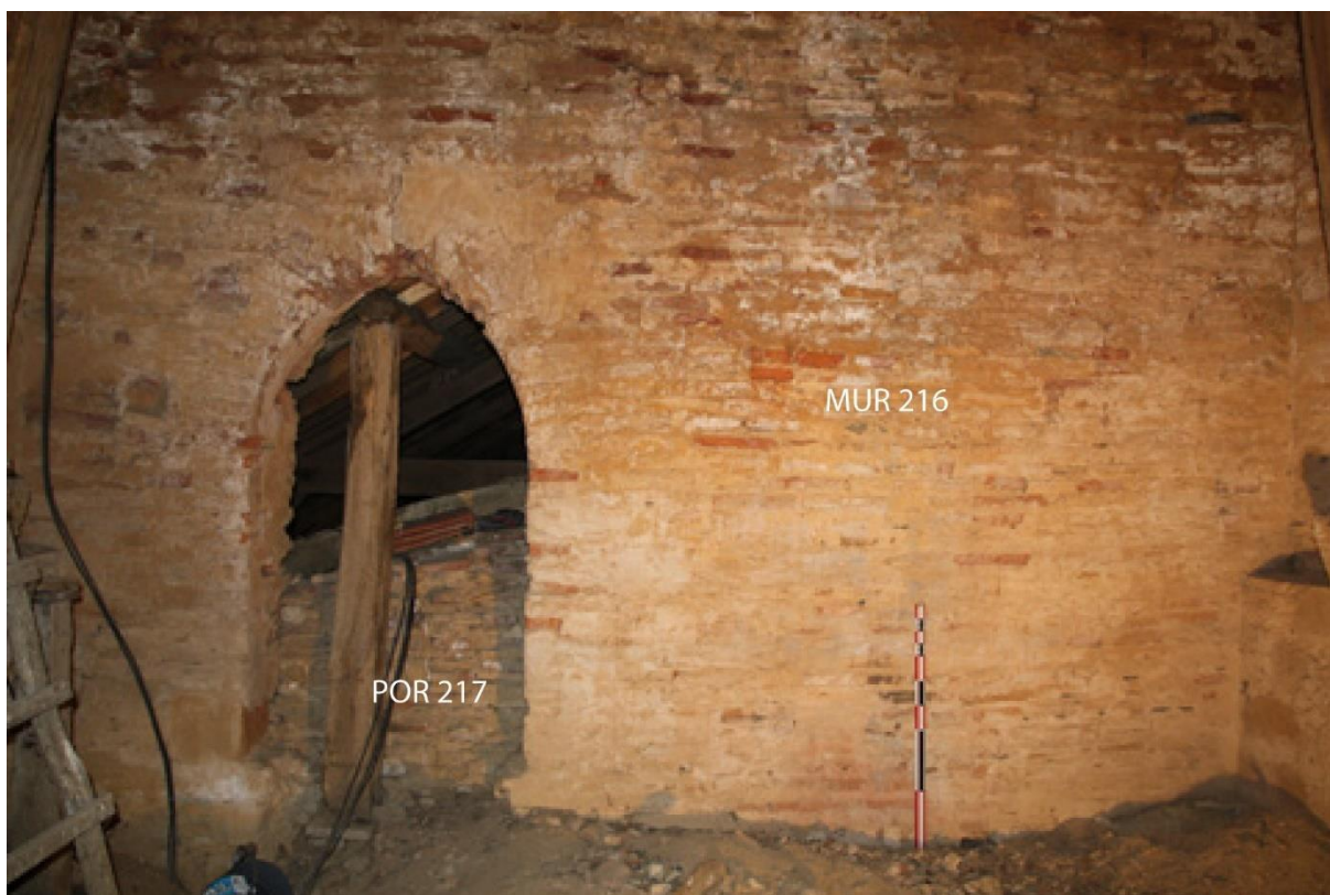
Fig. 17 - Surélévation du mur de chevet en maçonnerie de brique ouvrant actuellement sur les combles de la nef (Y. Mattalia)
