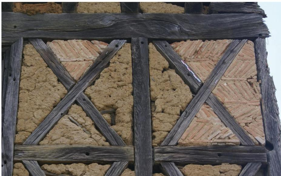
Fig. 25 - Panneaux hourdis en briques cuites de la façade orientale, 1er étage (A. Klein)
