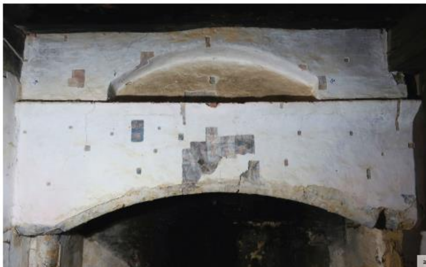
Fig. 27 - Cheminée de la grande salle du rez-de-chaussée et son décor peint sondé (A. Aussilloux)
