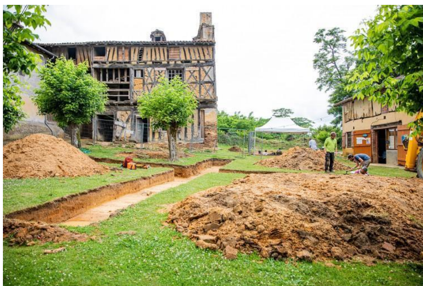
Vue du chantier
