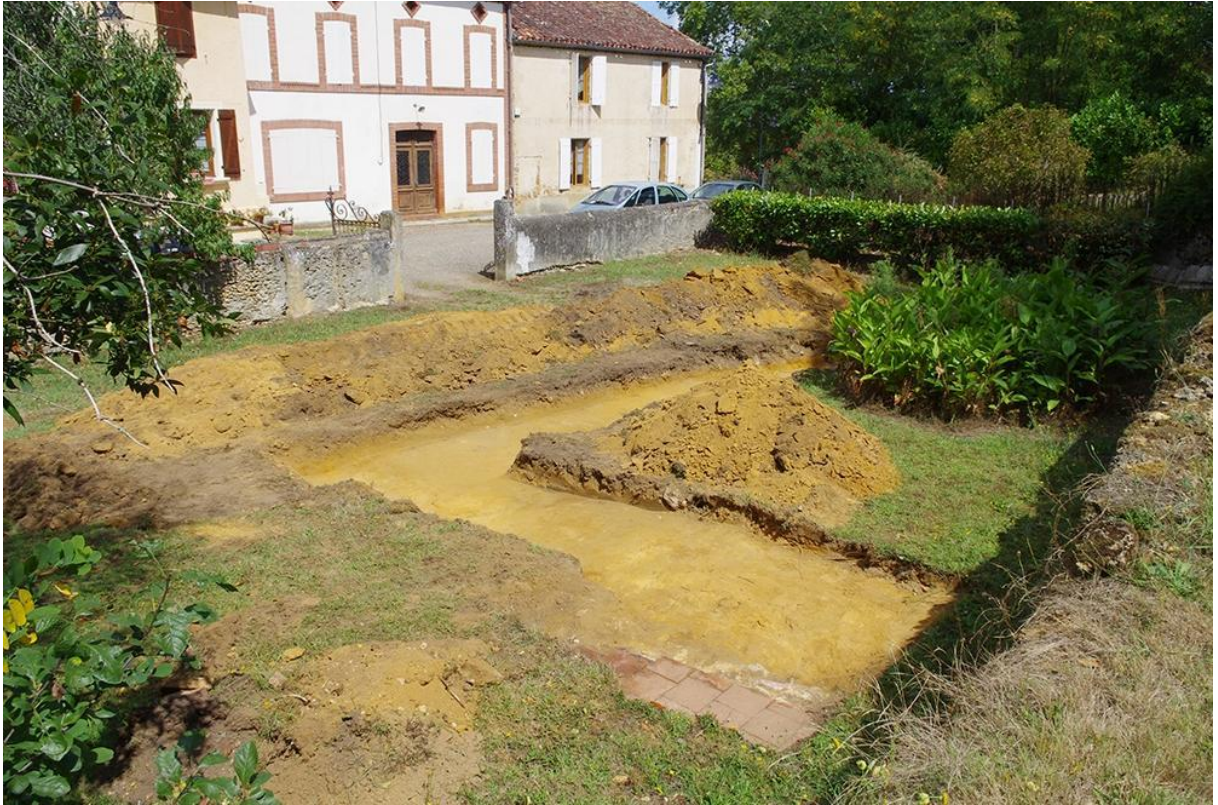
Fig. 37 - Vue générale du sondage 2 depuis l'ouest, au premier plan le sol de tomette 1034
