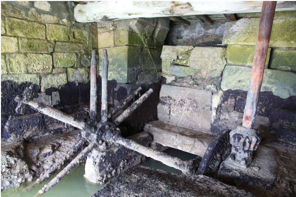
Mécanisme du moulin à marée de Loix (cl. B. Gissinger)
