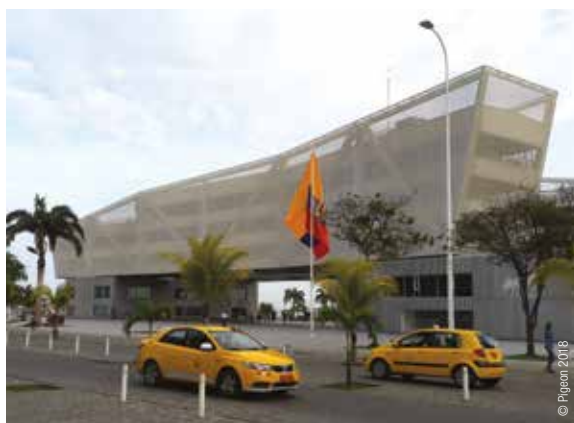
El edificio matriz de la Flopec en la playa Las Palmas (norte de Esmeraldas)
