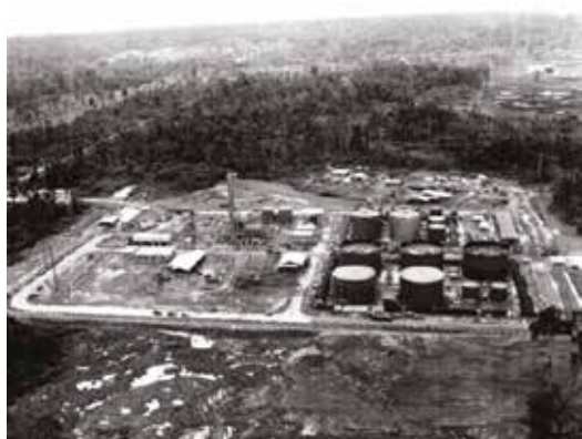
La refinería en construcción
