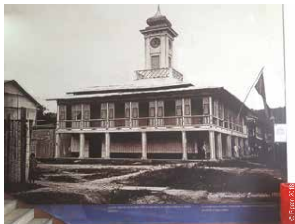
La Alcaldía de Esmeraldas en 1908 (fotografía exhibida a la entrada del edificio actual)
