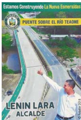
Cartel de la municipalidad en promoción de las obras
