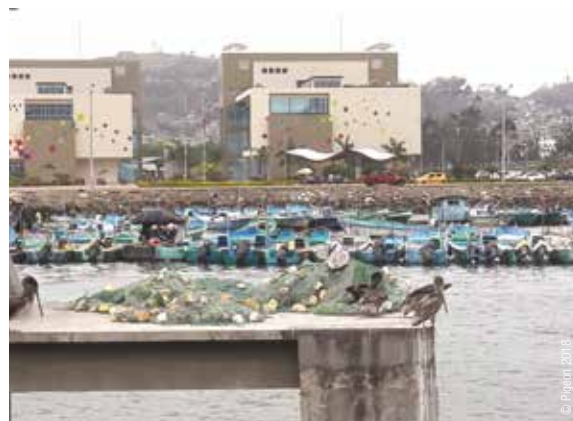
El edificio del CAC en la cercanía del puerto de pesca
