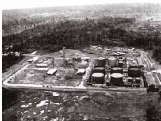
La refinería en construcción
